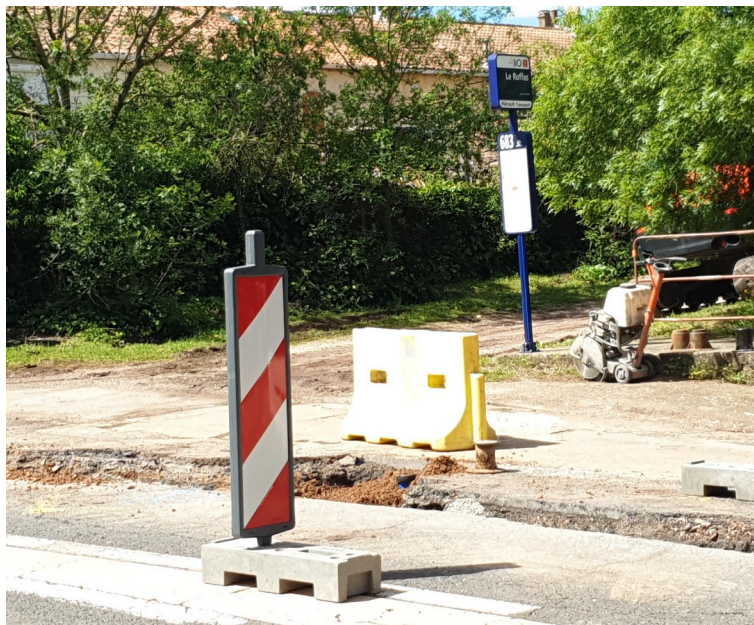
En travaux en mai 2024
